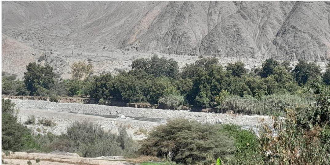
FIGURA N°02: SE OBSERVA QUE EL TRAMO HA SIDO DESCOLMATADO PERO SE REMITE LA ACTUALIZACION DE LA FTR ANTE UNA PROXIMA AVENIDA PARA MANTENIMIENTO DE CAUCE
